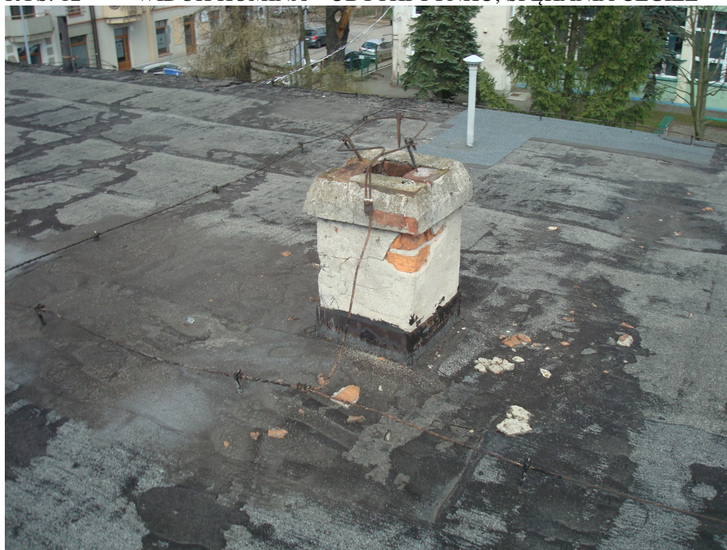
RYS. 12 WIDOK KOMINA – UBYTKI TYNKU, SPEKANIA CEGIEŁ
