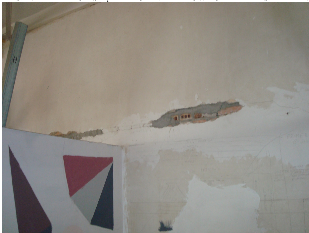
RYS. 17 WIDOK SPĘKAŃ ŚCIAN DZIAŁOWYCH W PRZESTRZENI WIĄZARA
