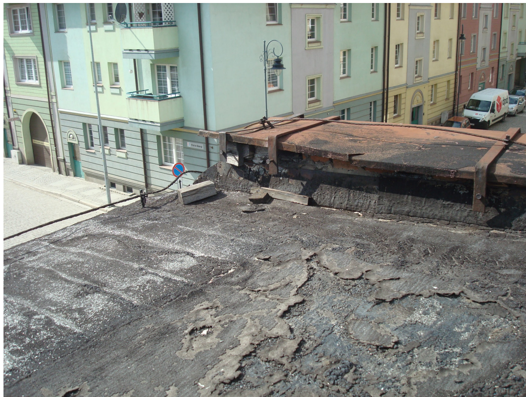
RYS. 9 WIDOK SKORODOWANYCH OBRÓBEK BLACHARSKICH ORAZ USZKODZONEJ PAPY
