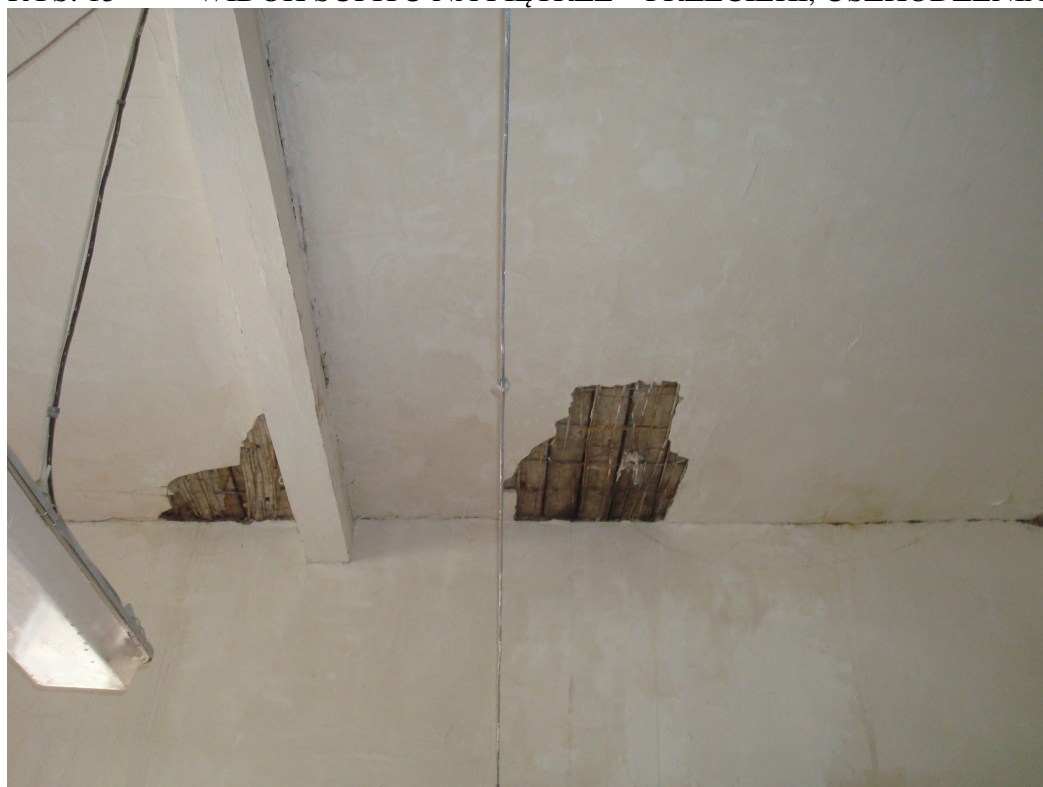
RYS. 15 WIDOK SUFITU NA PIĘTRZE – PRZECIEKI, USZKODZENIA TYNKU
