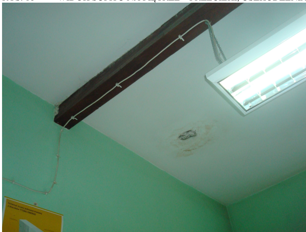
RYS. 16 WIDOK SUFITU NA PIĘTRZE – PRZECIEKI, USZKODZENIA TYNKU
