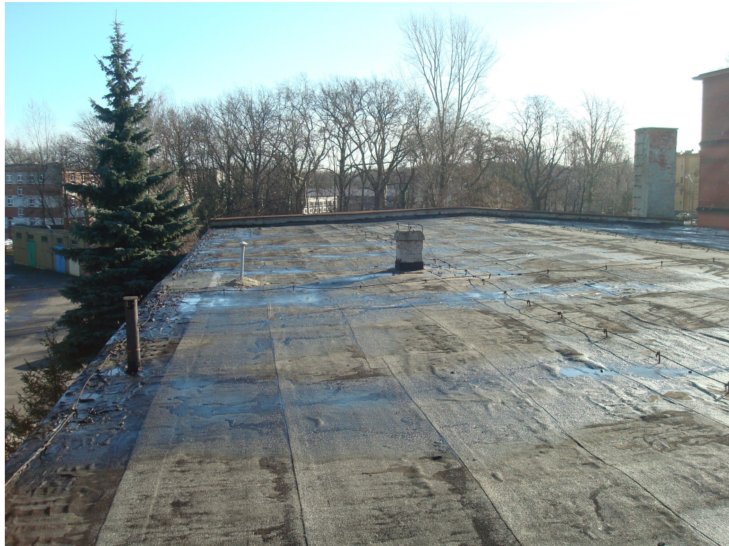
RYS. 7 WIDOK POKRYCIA DACHU – ZNISZCZONE POKRYCIE PAPOWE
