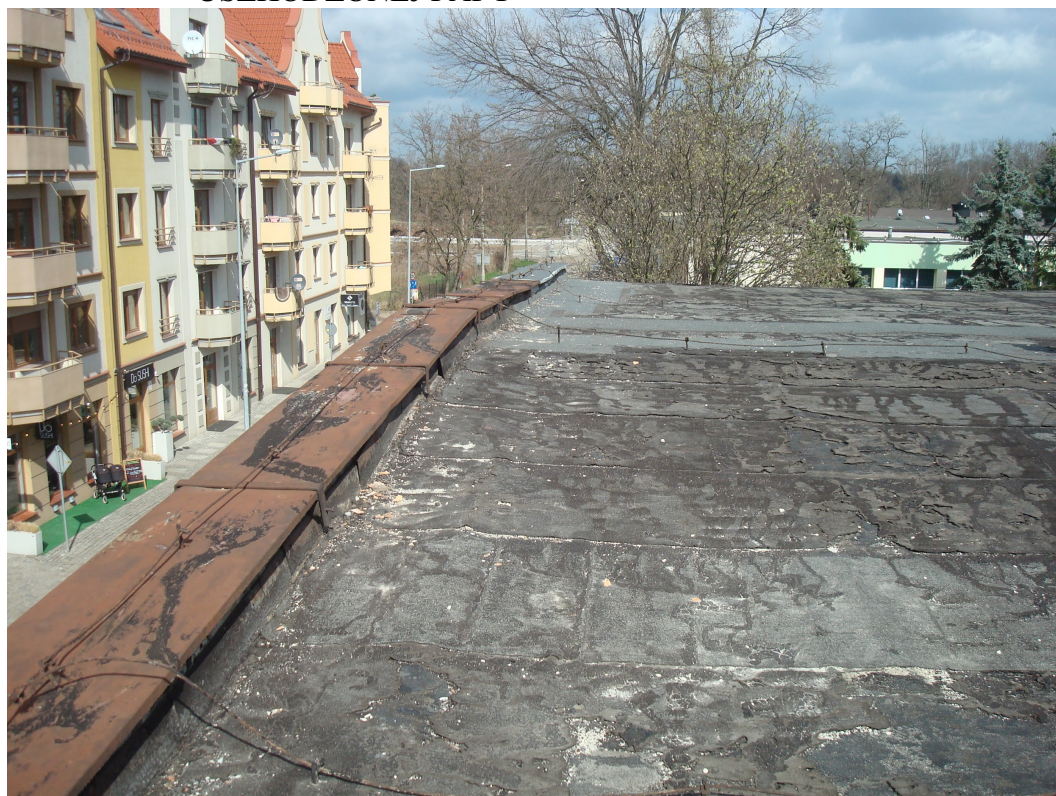
RYS. 10 WIDOK SKORODOWANYCH OBRÓBEK BLACHARSKICH ORAZ USZKODZONEJ PAPY
