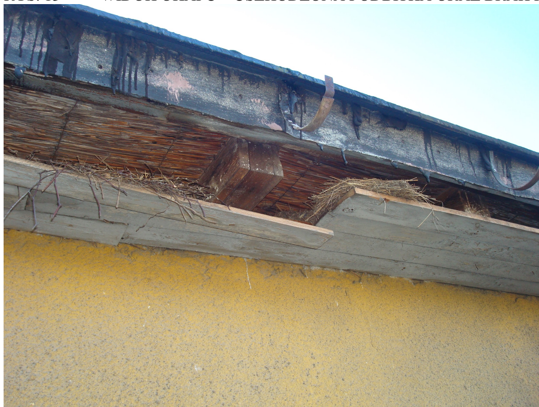
RYS. 13 WIDOK OKAPU – USZKODZONA PODBITKA ORAZ BRAK RYNNY
