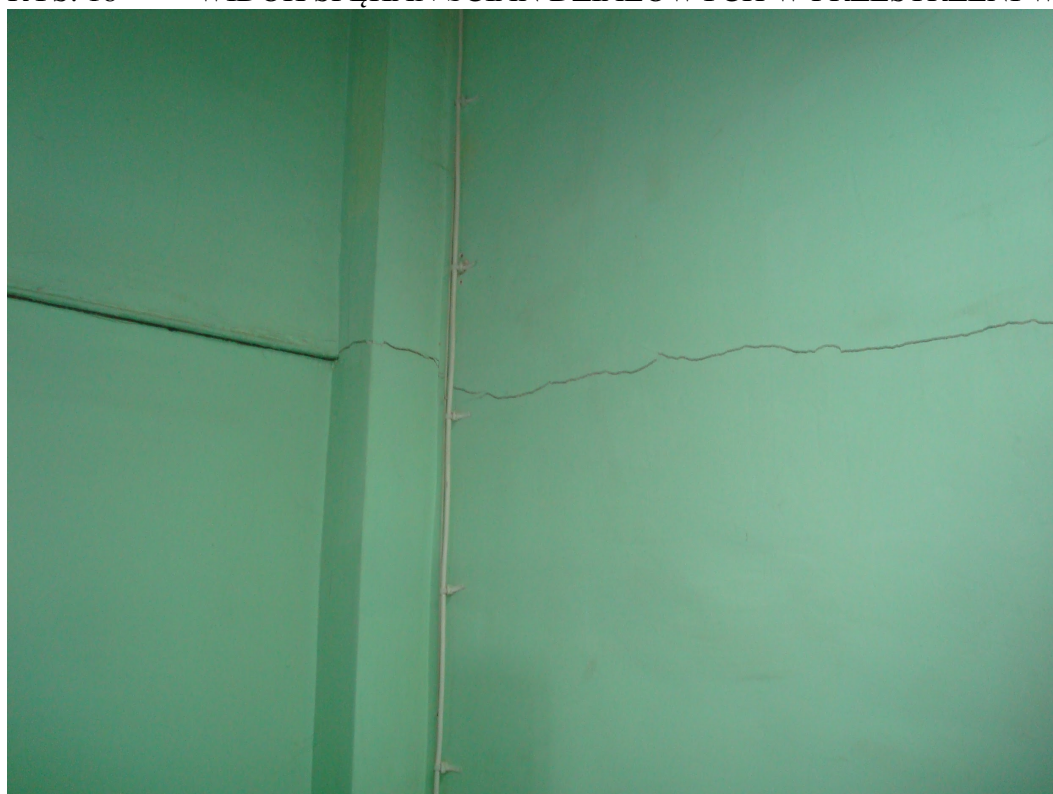
RYS. 18 WIDOK SPĘKAŃ ŚCIAN DZIAŁOWYCH W PRZESTRZENI WIĄZARA
