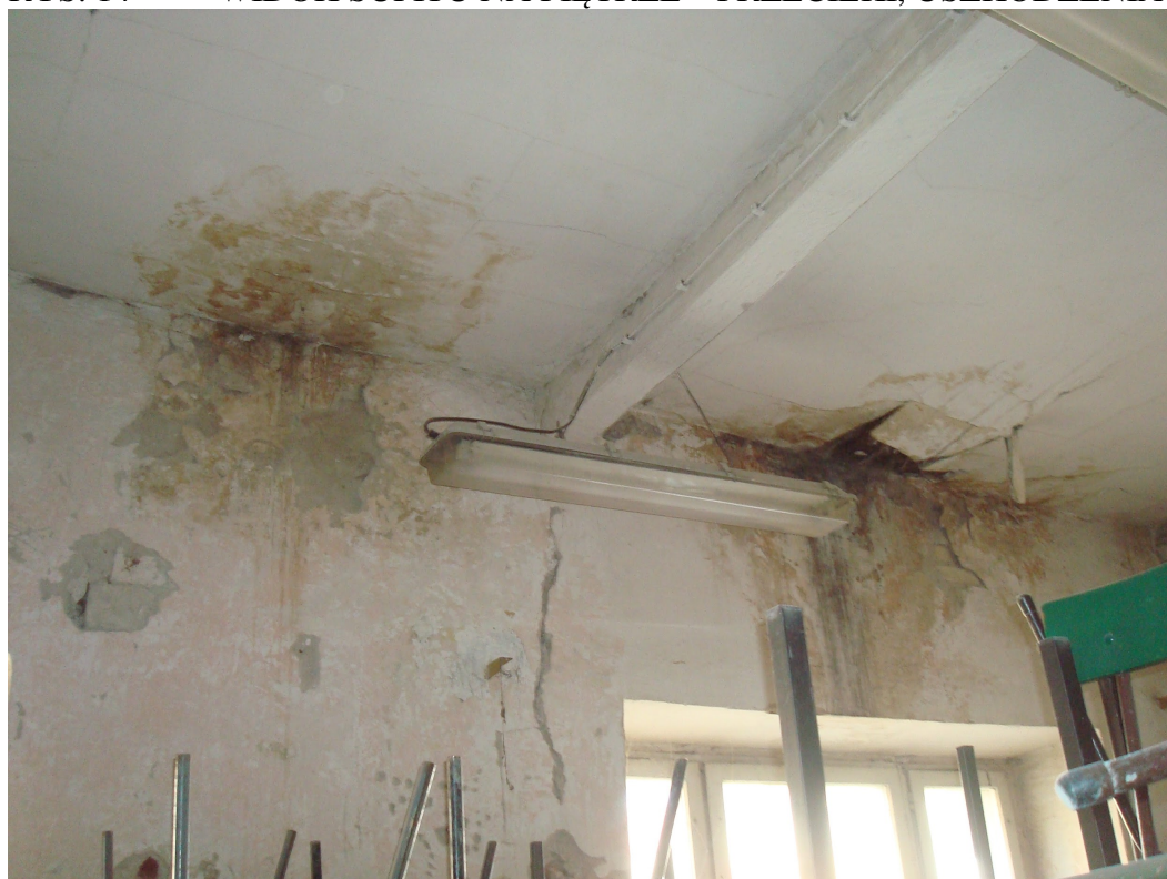
RYS. 14 WIDOK SUFITU NA PIĘTRZE – PRZECIEKI, USZKODZENIA TYNKU
