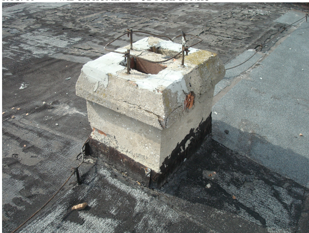
RYS. 11 WIDOK KOMINA – UBYTKI TYNKU
